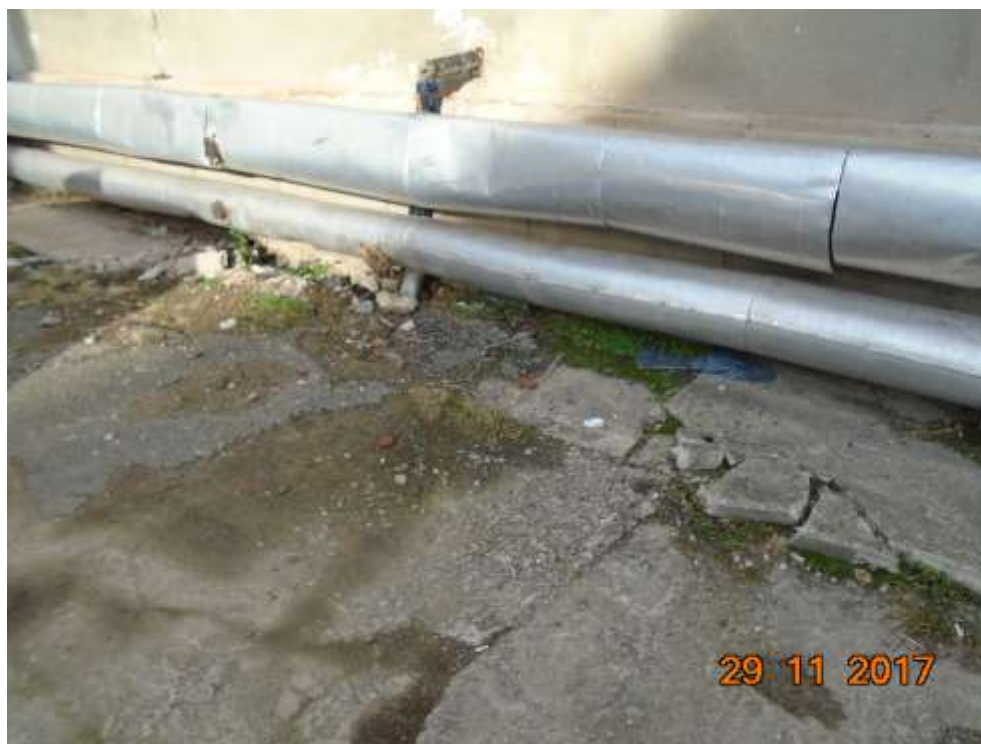
Foto 6-trotuar degradat, partial contrapanta si lipsa etanseitate trotuar-fundatie
