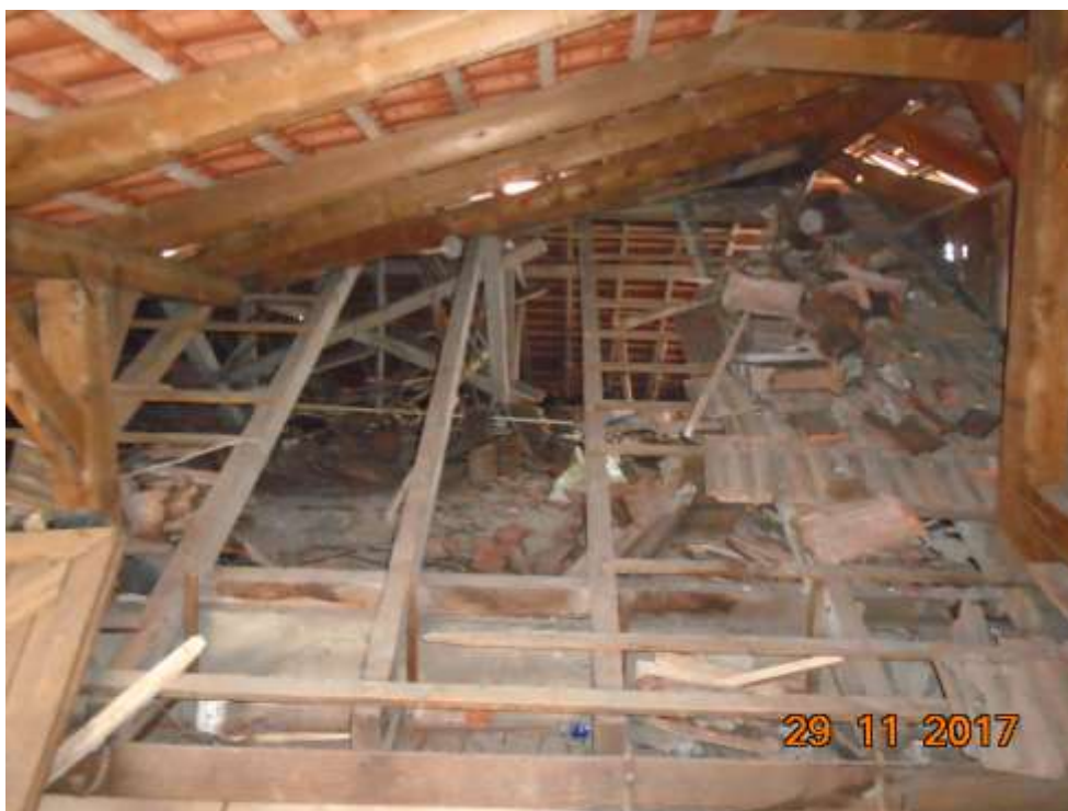
Foto 10- sarpanta din lemn si se inlocuieste invelitoarea din tigla ceramica
