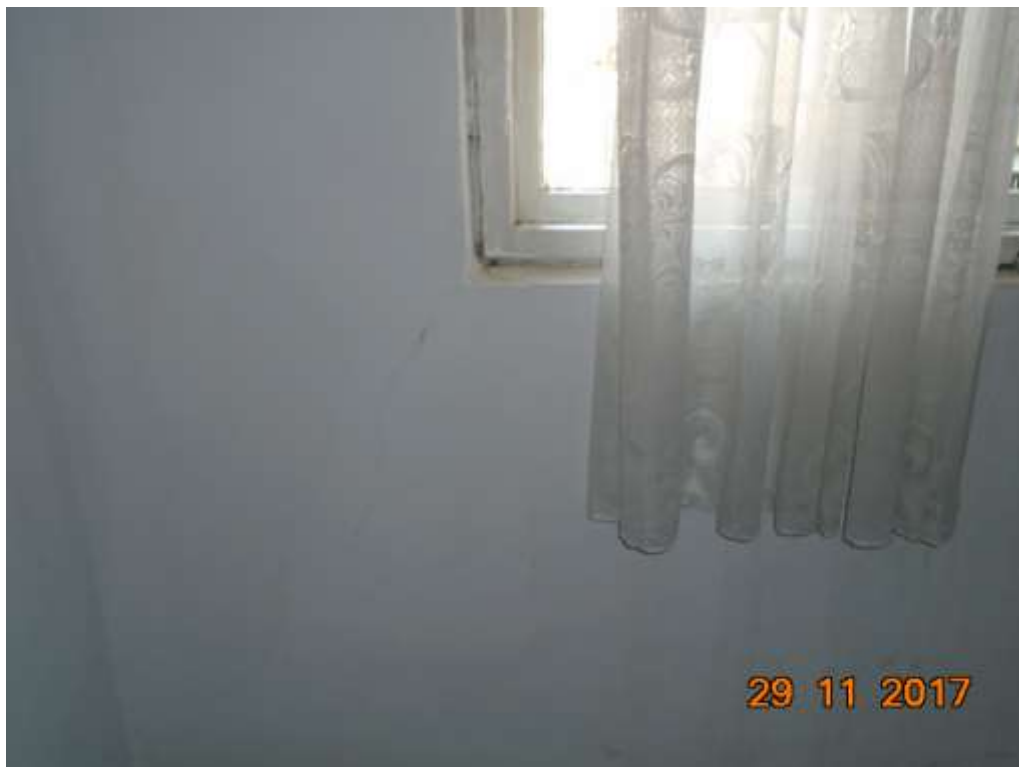
Foto 9- fisura locala identificata in pereti (zona casei scarii)
