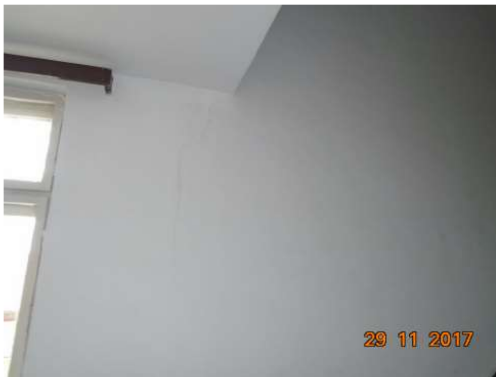
Foto 8- fisura locala identificata in pereti (zona casei scarii)
