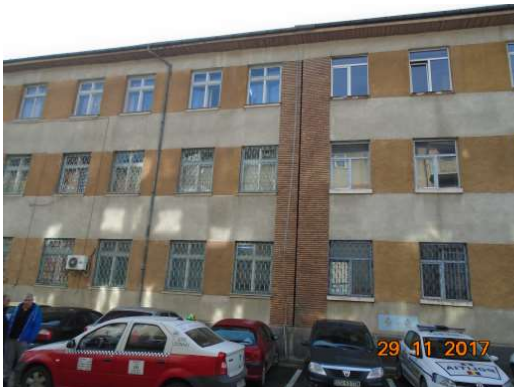
Foto 5-rost de tasare in fatada principala
